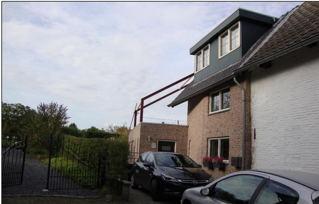
Oprit woning Rott 53
