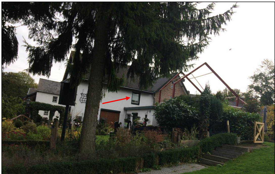
Achtergevels woningen Rott 51 en 53 (1)
